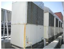
室外器も室内器同様に アルミフィンの熱交換器が 組込みされています。 室外器は、外装が風雨にさらされることにより錆や汚れの付着 が目立ちます。
