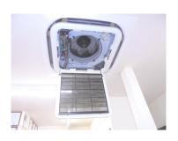
室内器には、温度を調整するために熱交換器が組み込まれてます。 本体は、空気中の汚れごと吸引しますので予想以上に汚れがつきます。
