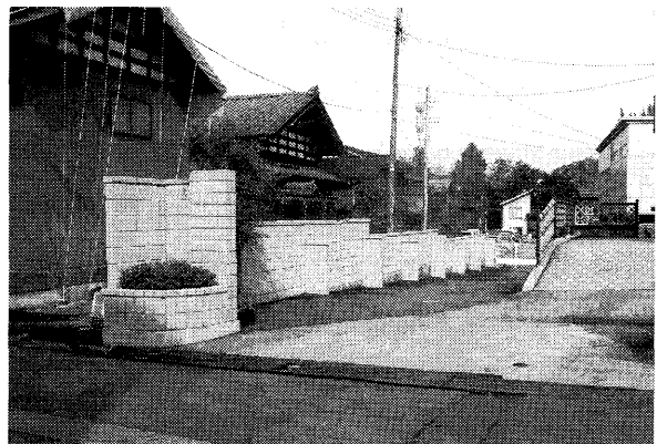
写真3-8 健全な化粧コンクリートブロック塀の例(十日町)
