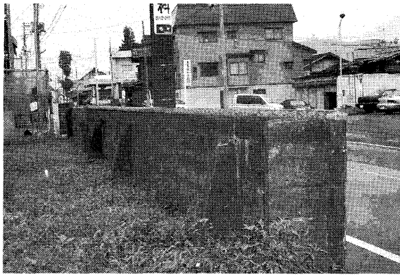
写真3-7 健全なコンクリートブロック塀の例(十日町)
